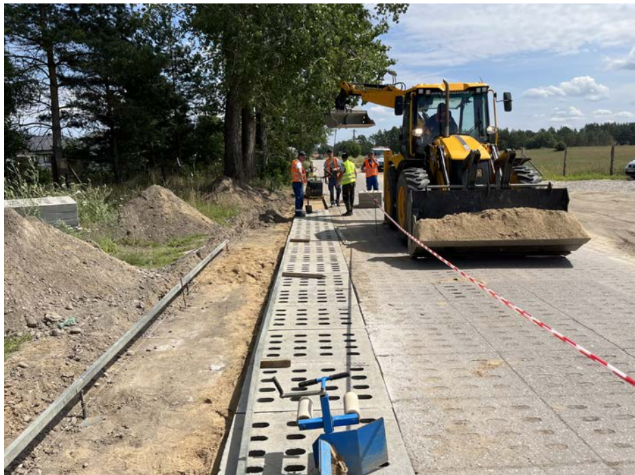
Prace na ulicy Majora Bojana
