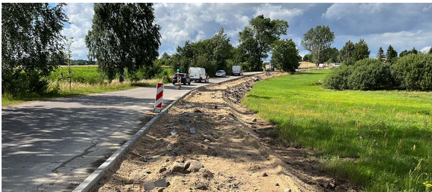
Ulica Gryfa Pomorskiego w trakcie prac, na odcinku Kielno - Warzno
