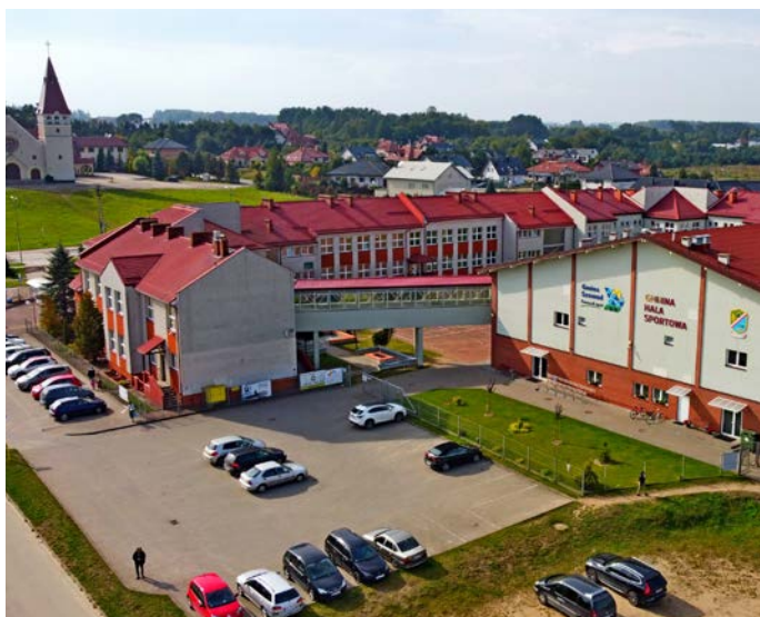
Kompleks szkolno-sportowy w Bojanie
