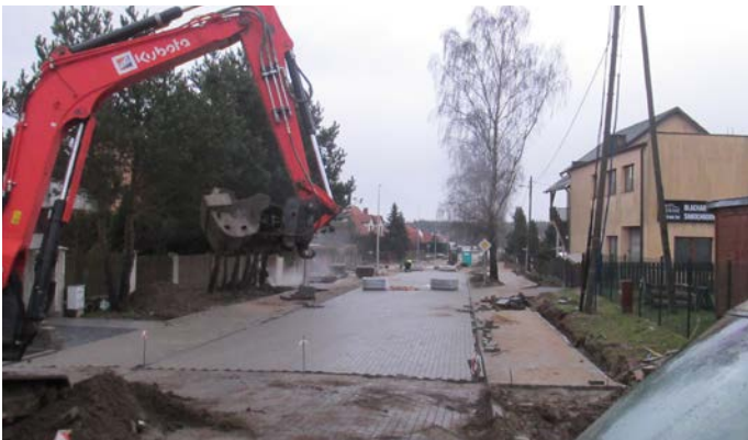
Utwardzenie kostką – Bojano, ul. Gryfa Pomorskiego
