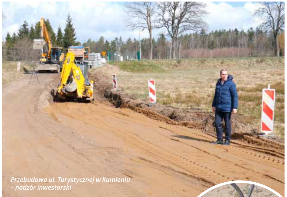
Przebudowa ul. Turystycznej w Kamieniu
