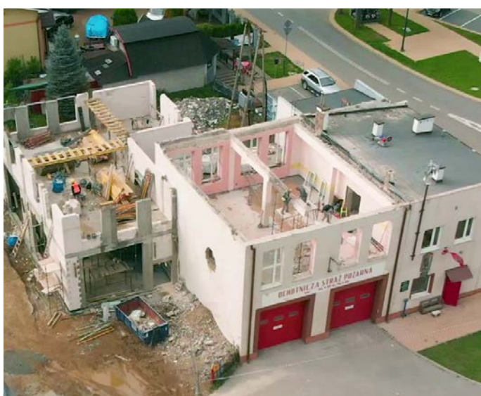
Kielno, remont i rozbudowa remizy OSP
