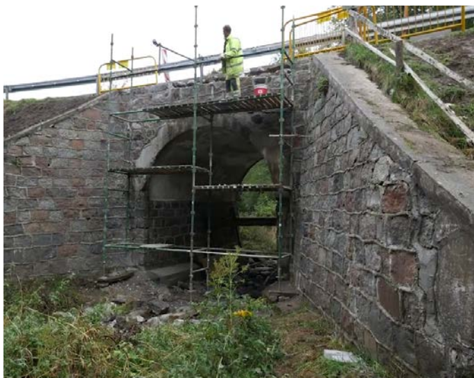
Będargowo, remont mostu
