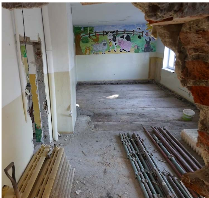
Kielno, remont starej szkoły
