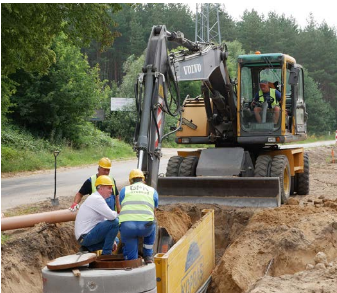
Koleczkowo, budowa kanalizacji
