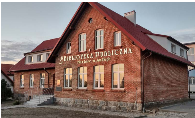
Nowe siedziby bibliotek – Łebno, Kielno, Szemud (w budowie)
