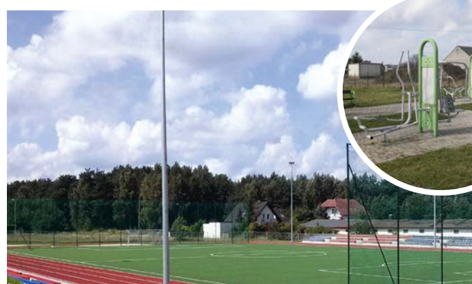
Kompleksowa rozbudowa obiektów sportowych i placów zabaw
