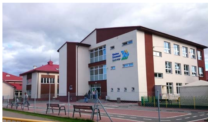
Rozbudowa szkoły w Szemudzie (2017-2020)
