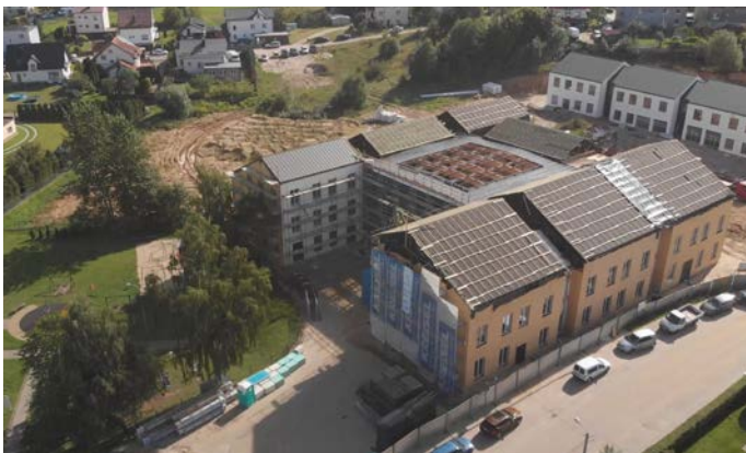
Centrum Samorządowe w Szemudzie (w budowie)
