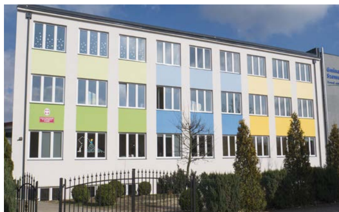
Termomodernizacja obiektów szkolnych (2015-2019)
