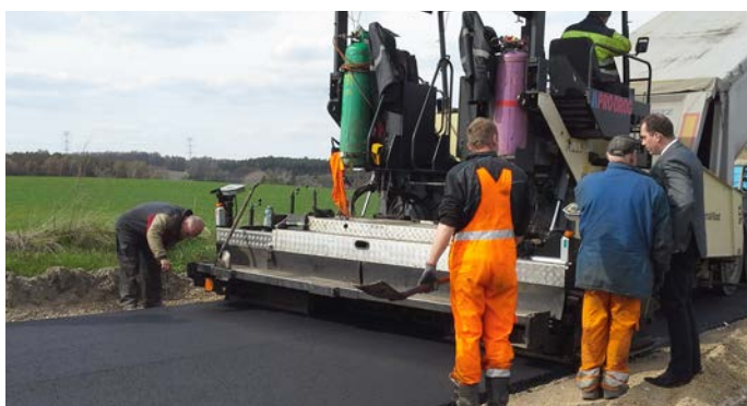
Intensywne utwardzanie dróg gminnych – ok. 70 km (2013-2021)
