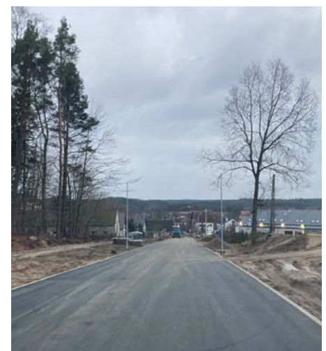
Koleczkowo, ul. Kieleńska w trakcie budowy – dojazd do węzła koleczkowskiego Trasy S6
