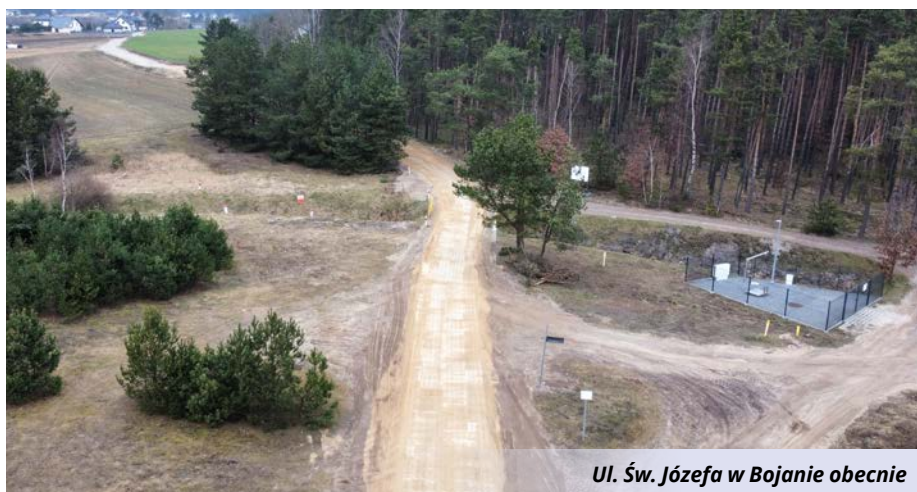
GPK Szemud w trakcie prac budowlanych przy ul. Św. Józefa w Bojanie
