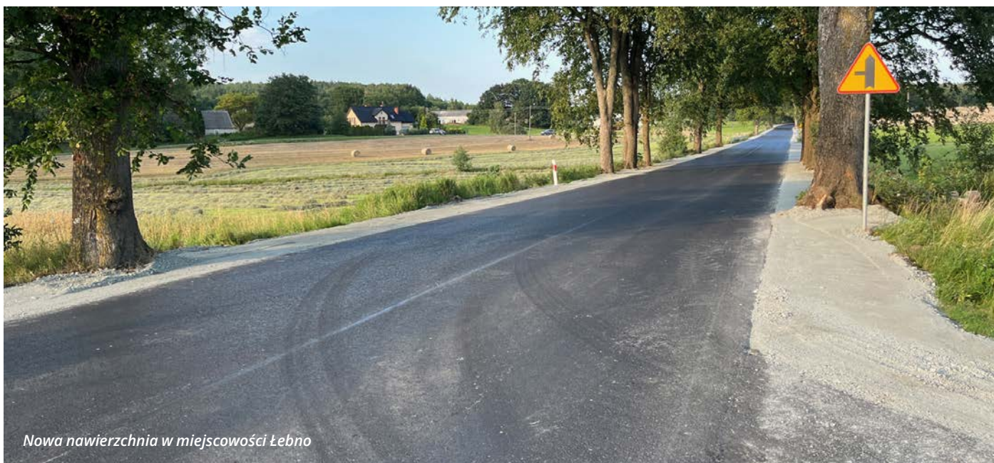
Nowa nawierzchnia asfaltowa na trasie Łebno-Donimierz
