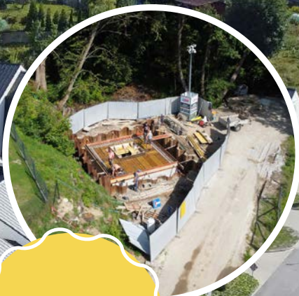
Modernizacje przepompowni ścieków
