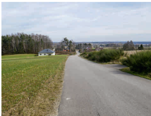
Droga Leśno-Rębiska – obecnie
