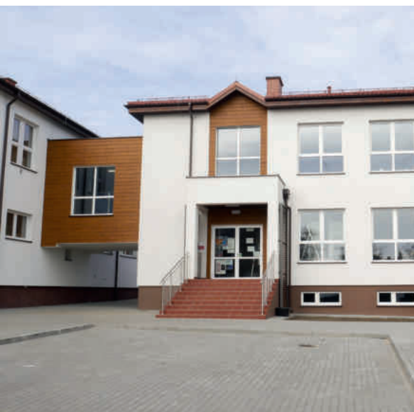
Nowa część szkoły w Kielnie
