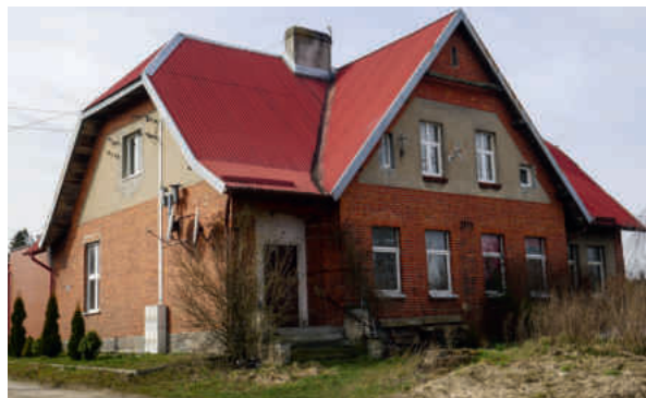
Budynek dawnej szkoły w Rębiskach
