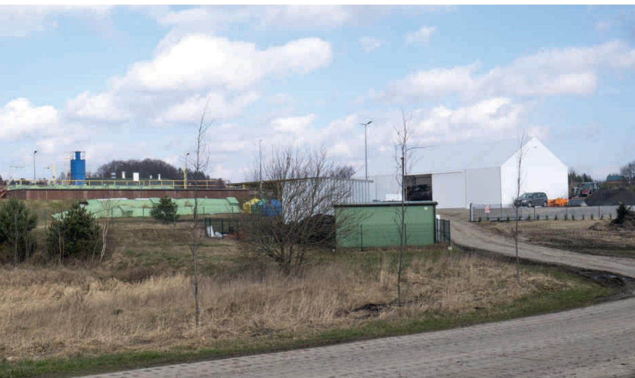
Oczyszczalnia ścieków w Szemudzie
