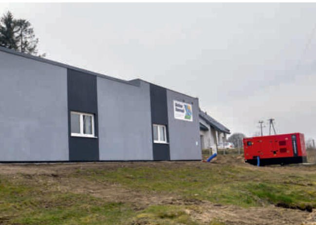
Zmodernizowane ujęcie wody w Szemudzie
