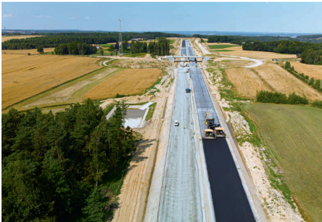
Trasa S6 w budowie – lato 2020
