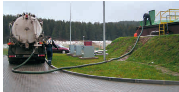
Zrzut ścieków pochodzących ze zbiorników bezodpływowych
