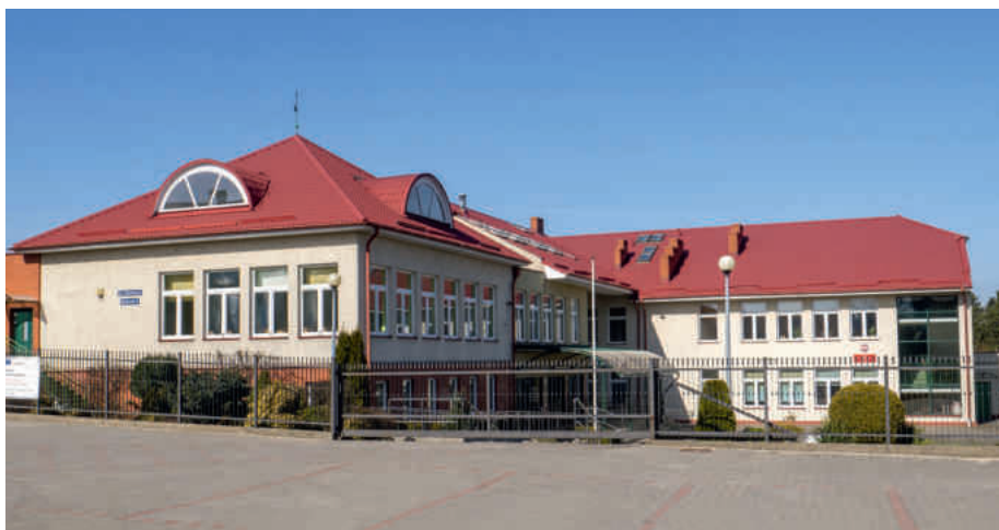
Szkoła Podstawowa w Szemudzie (budynek dawnego gimnazjum)
