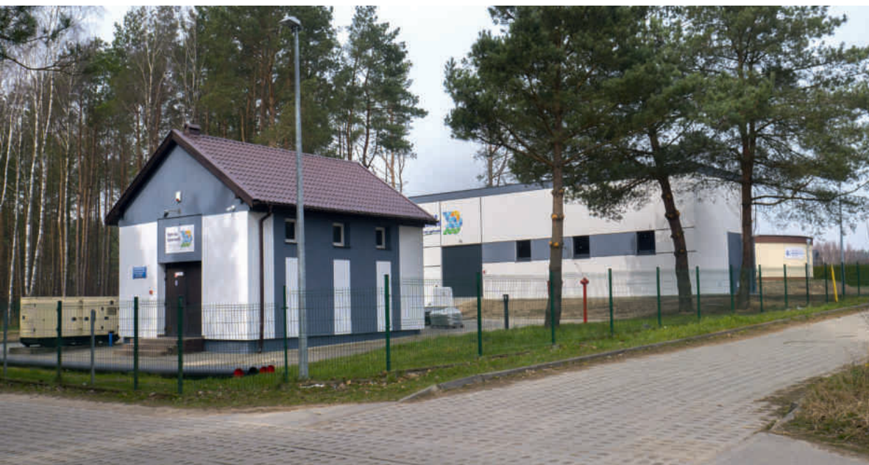
Rozbudowane ujęcie wody w Bojanie - nowoczesne studnie
