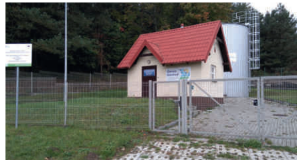
Zmodernizowane ujęcie wody w Koleczkowie
